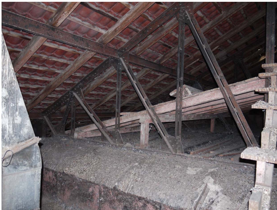
Krov nad jižní částí budova B se zachovaným stropem
