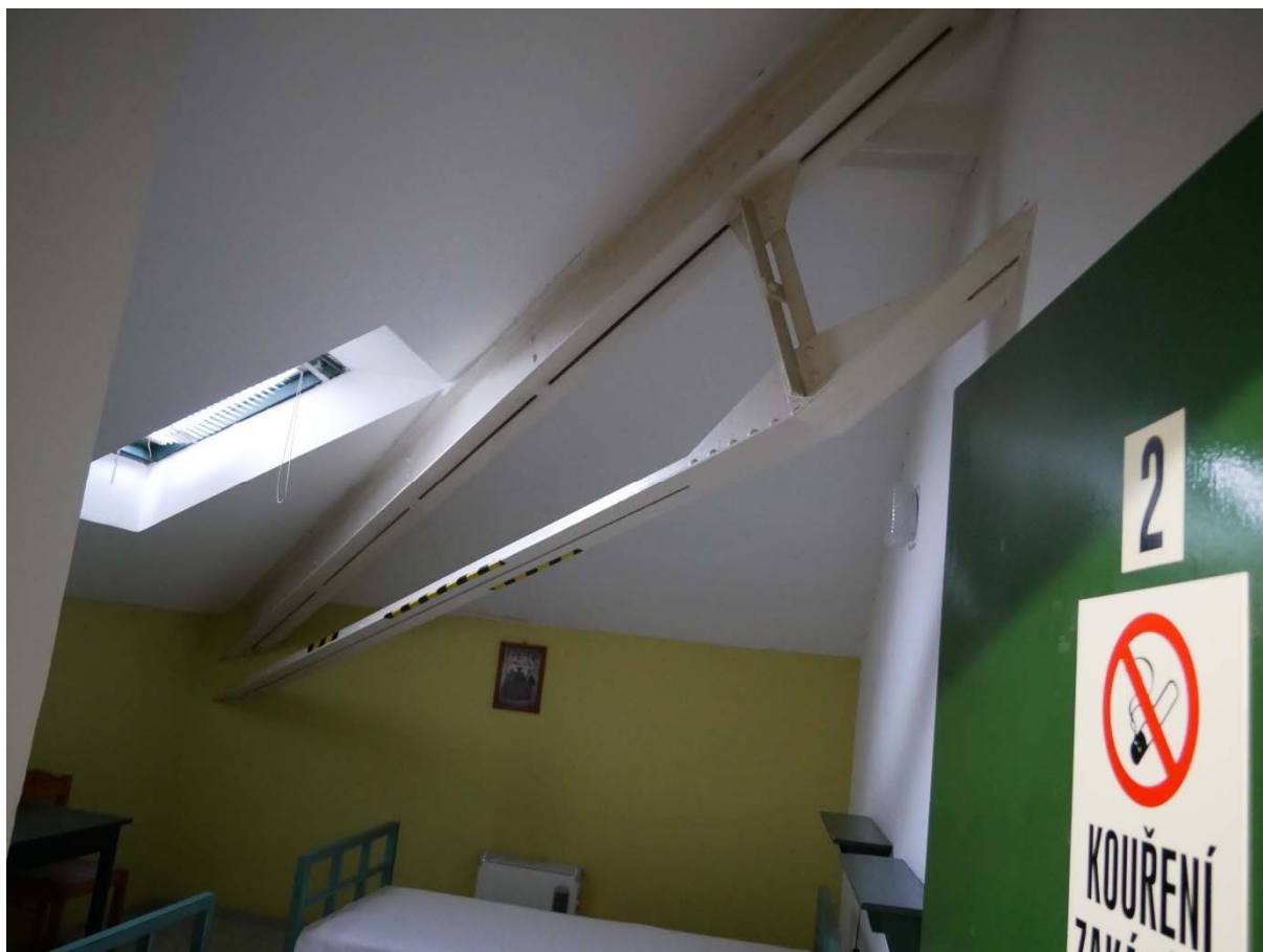
Konstrukce vazníků zabudované do podhledu půdní vestavby
