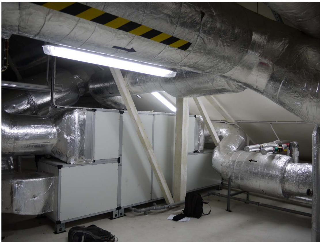
Severní část krovu nad budovou D s vestavěnou vzduchotechnikou
